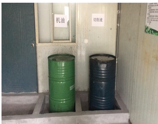
危废暂存处围堰
